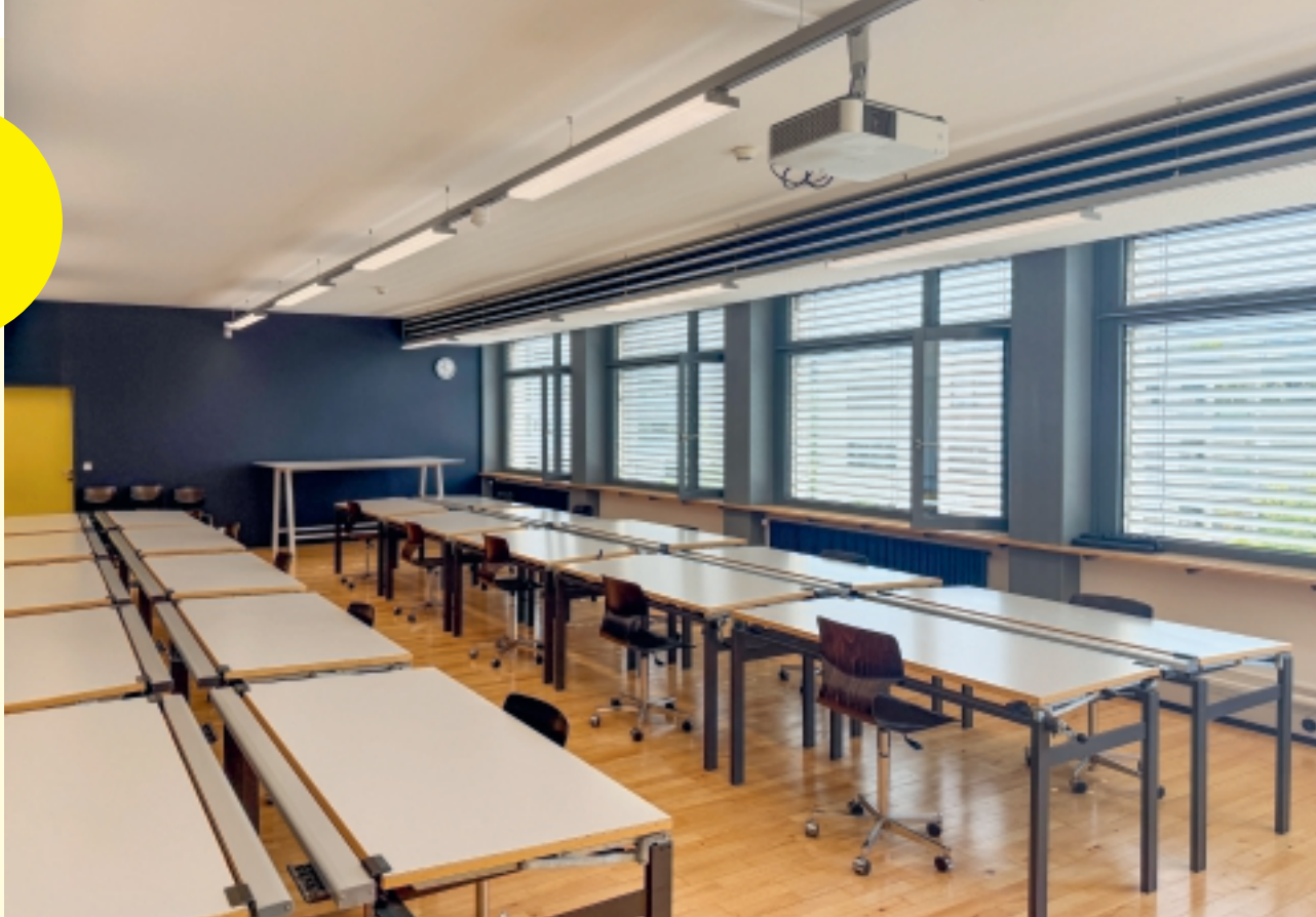
Abbildung 19: Innenansicht eines Schulzimmers mit modernisierter Beleuchtung (Bild: Stefan Gasser)
