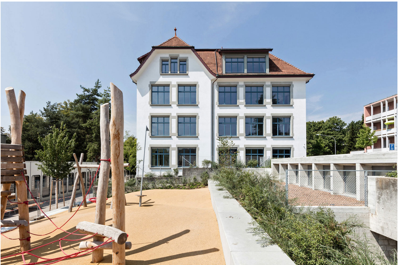
Abbildung 1: Aussenansicht des erneuerten Schulhaus Bläsi in Zürich-Höngg
