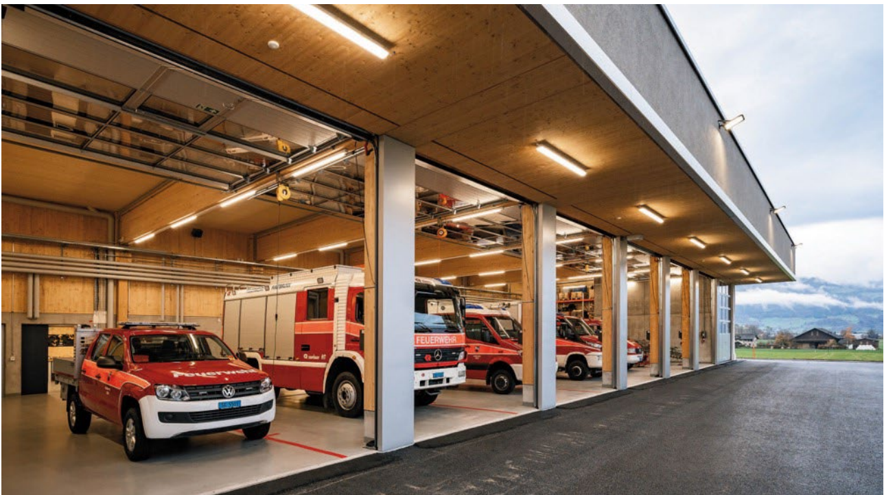
Abbildung 7: Feuerwehrdepot Einsatzzentrale in Kaltbrunn St. Gallen
