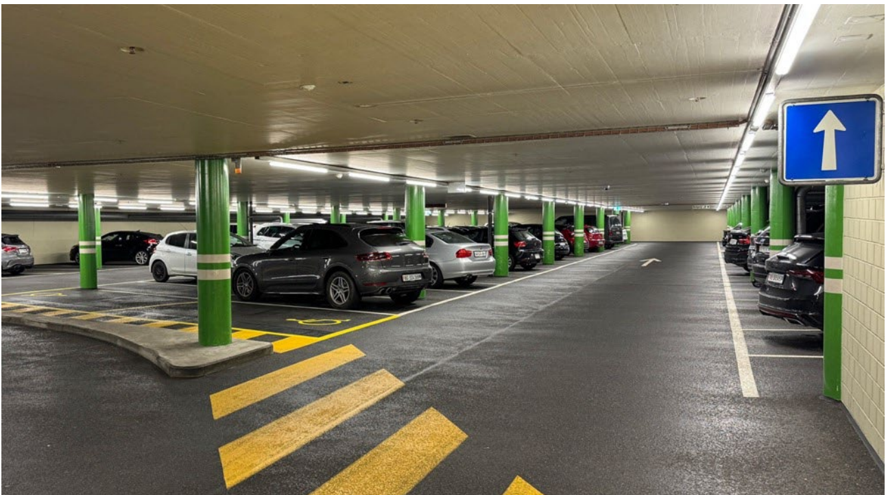
Abbildung 4: Innenansicht Parkgarage Obertor in Bremgarten
